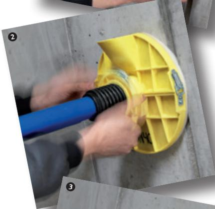
**2** Ausgussvorrichtung mit der dazu passenden Dichtscheibe an der Mauerdurchführung fixieren und den Klemmverschluss befestigen.
